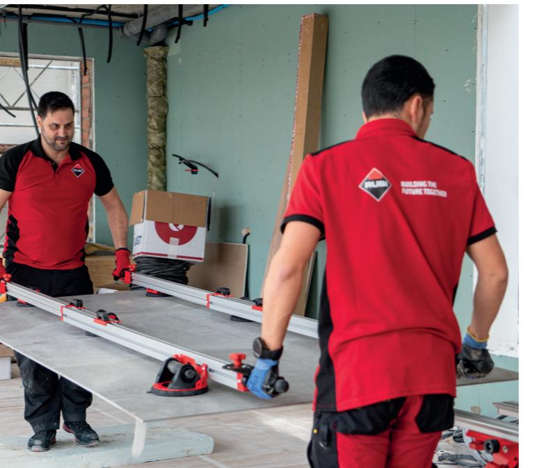
**ES** ERGO TILE TRANS transporta y coloca baldosas de gran formato de manera cómoda y segura. Sus ventosas de vacío móviles con indicadores de pérdida de presión garantizan una sujeción firme, sin imprevistos.
